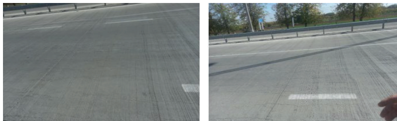
Рис. 2. Продольные трещины в покрытии
