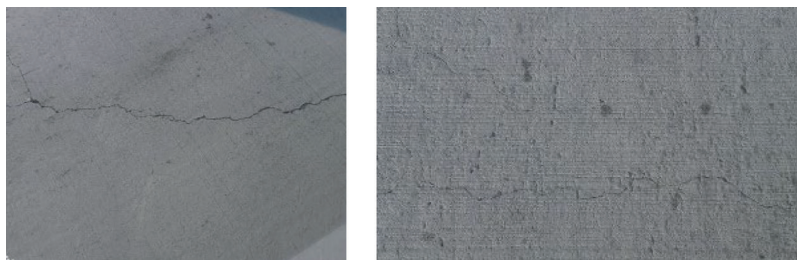
Рис. 1. Трещины поверхностной сетки
