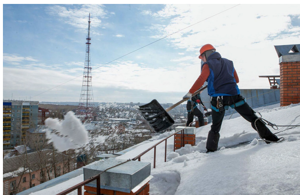
Рис. 1. Борьба с обледенением посредством механического способа
